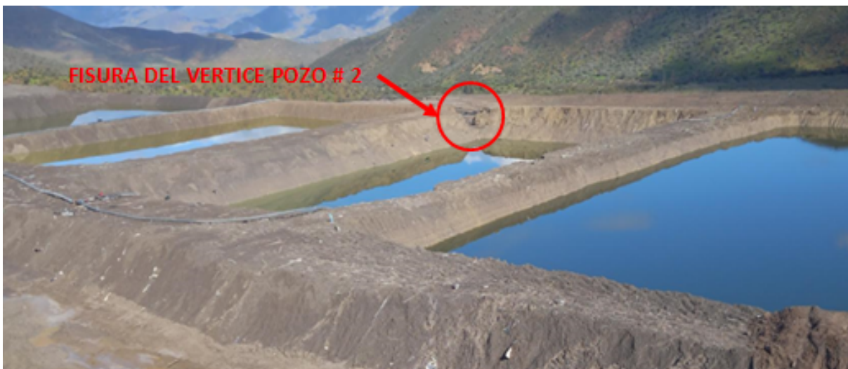
Fotografía # 2 sector de fisura por donde se produjo la fuga.
